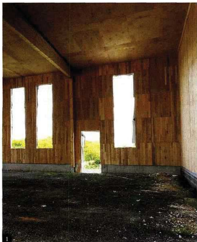
1 - Sur le chantier-test, les caissons en lamellé-croisé forment des logements de plain-pied. 2 - Caissons mis en œuvre pour une extension.
